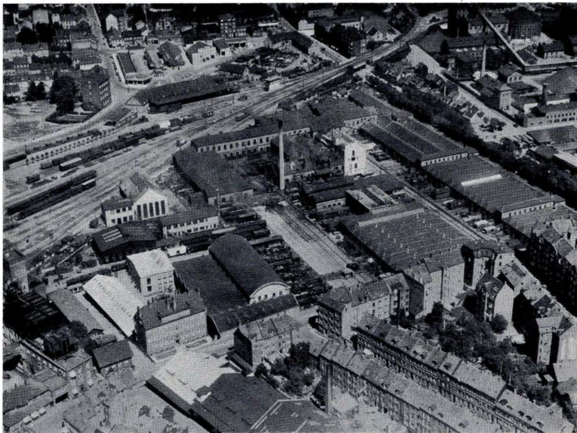
Fig. 357. Luftfoto af Centralværkstedet i Aarhus 1933.
